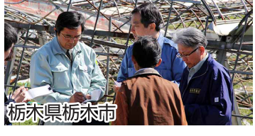
■栃木県議と共に雪害調査 栃木県栃木市
